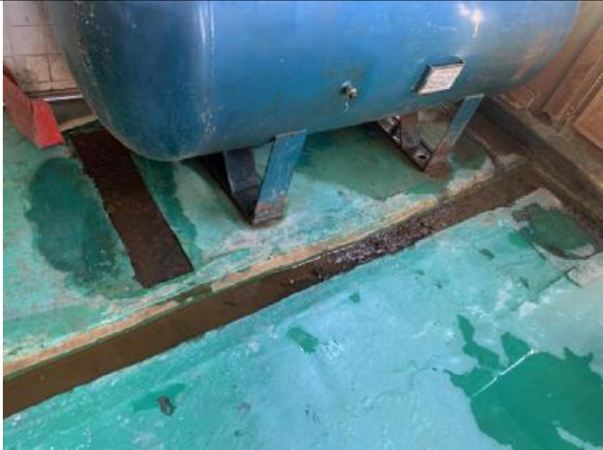
废水处理区地面
