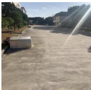
地下事故应急池
