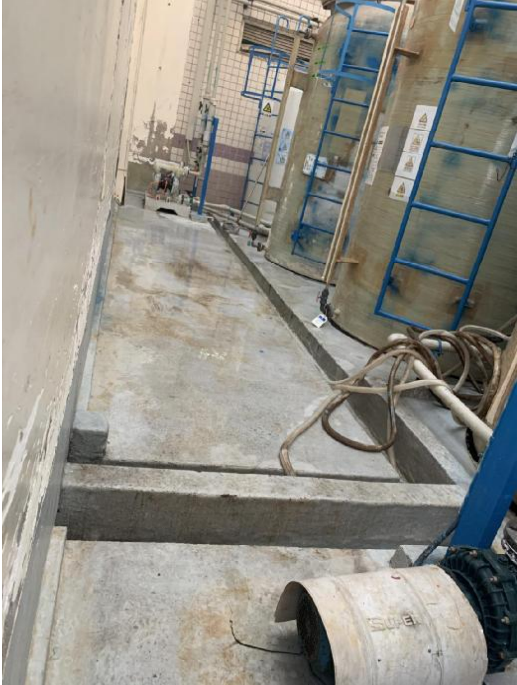
二厂废水站罐区
